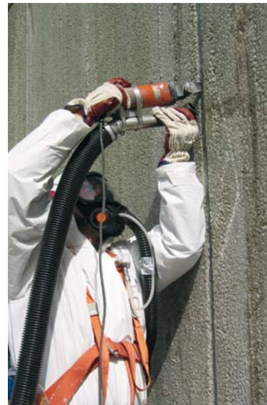
PCB-sanering av fogar.
