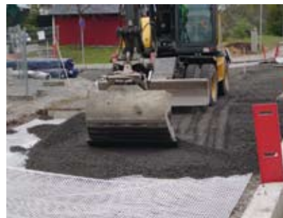
Återanvändning av restprodukter vid vägbyggnad.
